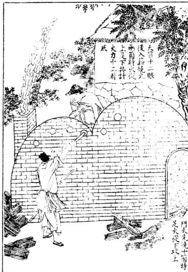
〔圖〕《天工開物》書中介绍瓷器燒製工法的瓷窯圖。
